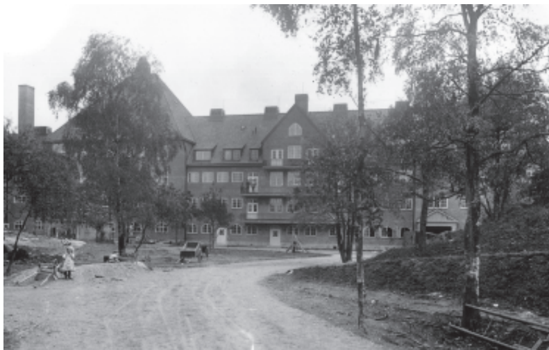
Norra fasaden med anläggningsarbeten, 1913. GSM.
