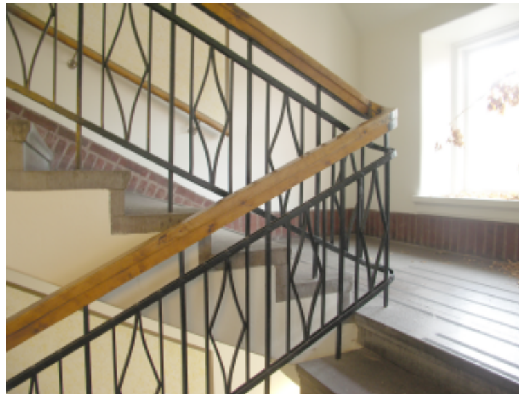
Bilder från huvudtrapphuset med bland annat den äldre branddörren till vinden.
