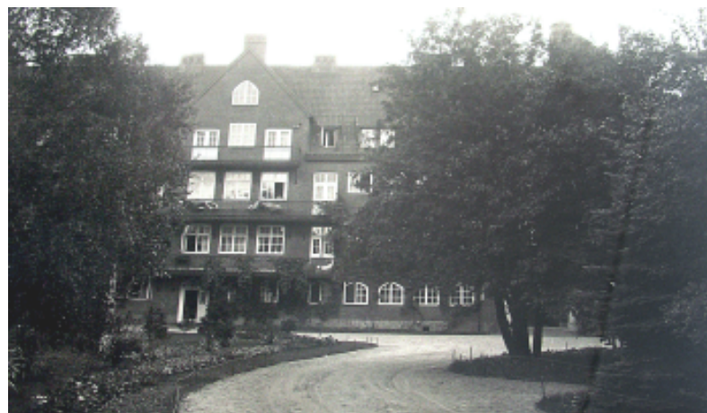
Fasadbild av huvudbyggnaden från norr. Här syns den äldre grusbeläggningen och planteringarna som ledde fram till huset. (å.o. )
