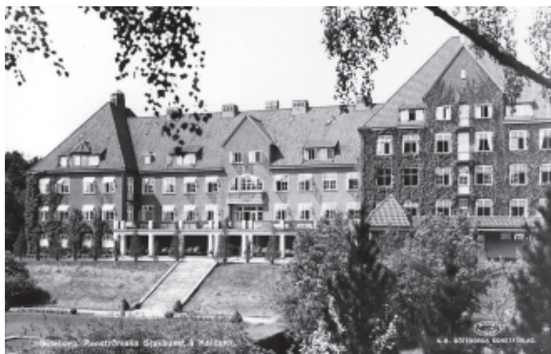
Vy över södra fasaden, troligen tagen på 1930-talet. GSM.
