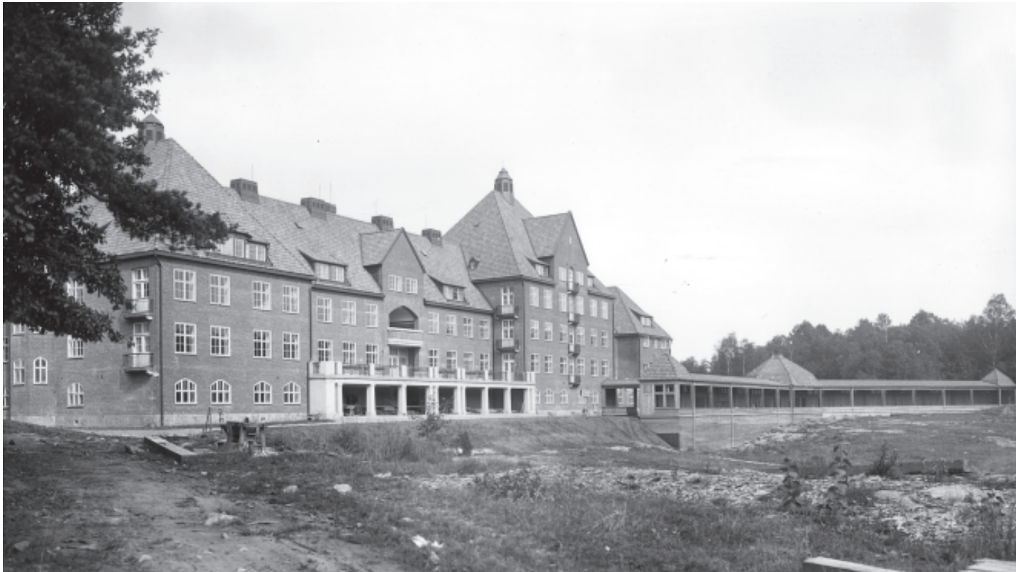
Södra fasaden 1913 med de idag rivna ligghallarna till höger i bild. GSM.
